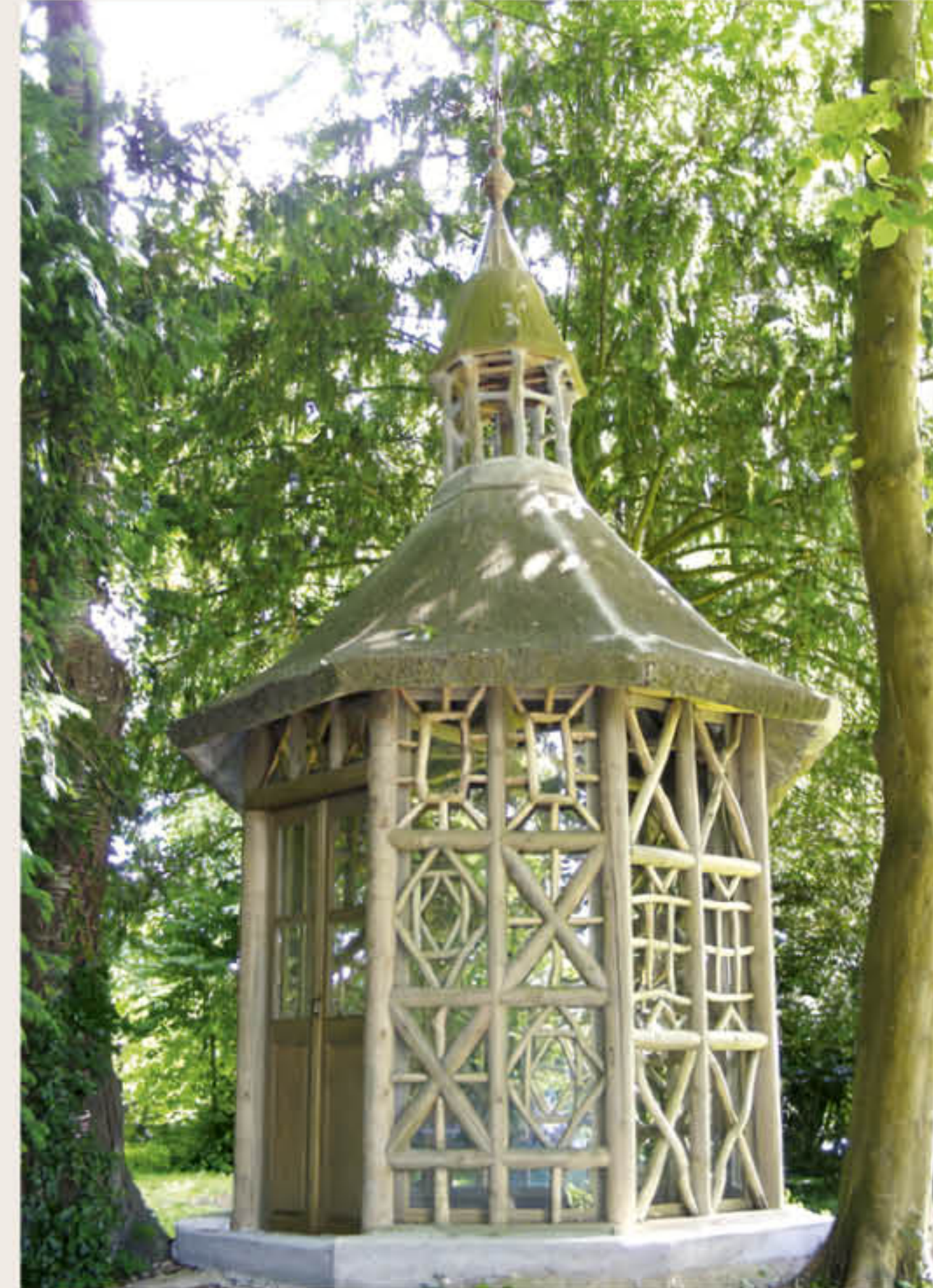
Gloriette réhabilitée par l'architecte Philippe LOYER
