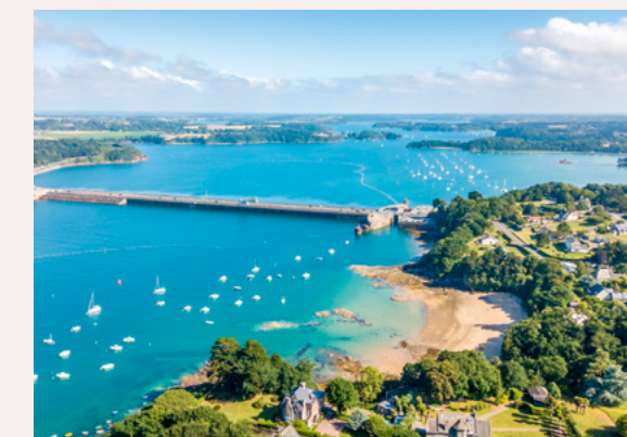
Barrage de la Rance
